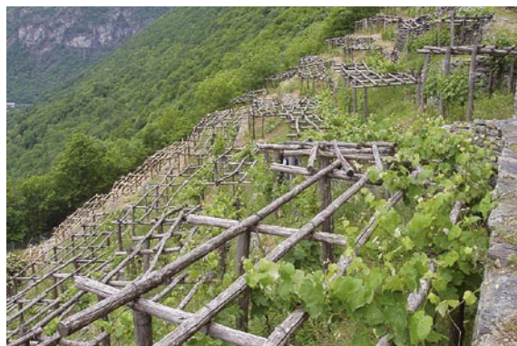
Die Pergolen für Reben wurden saniert, um den Weinertrag zu verbessern (Foto: BLW Bern)
